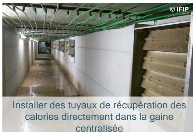
Installer des tuyaux de récupération des calories directement dans la gaine centralisée
