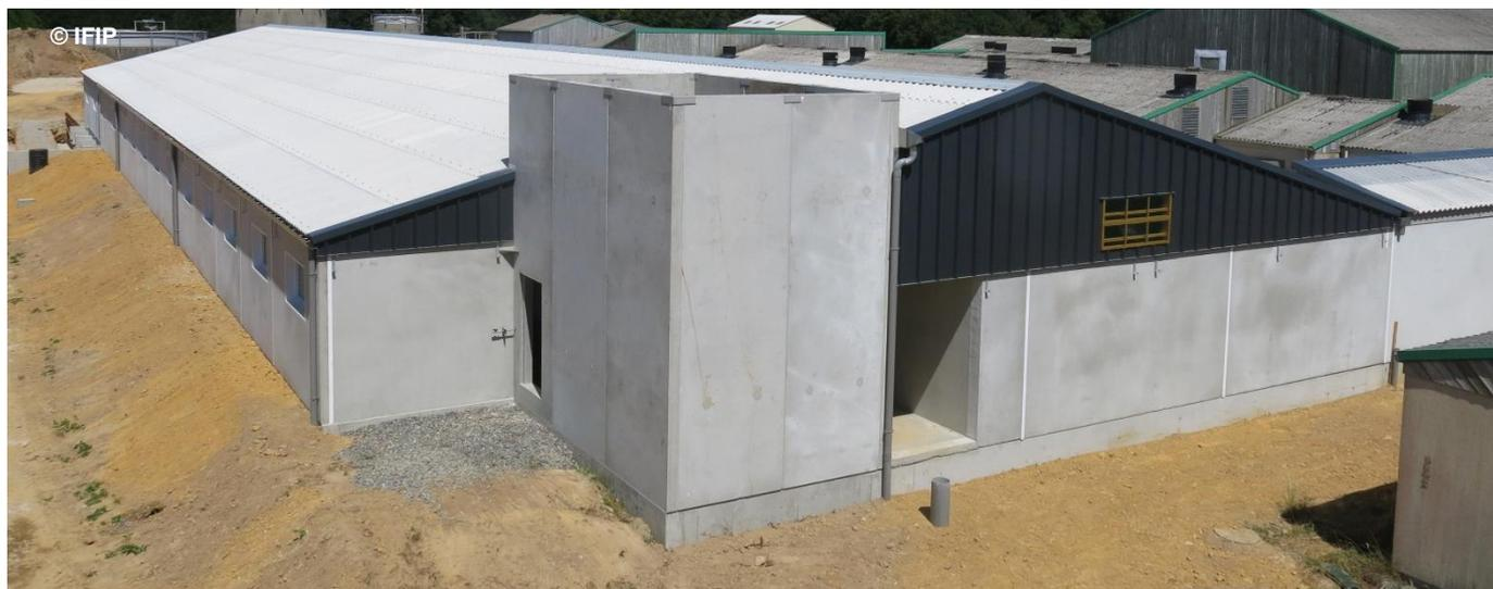
Canaliser l'air vicié des salles dans la gaine d'extraction d'une ventilation centralisée facilité l'installation d'un dispositif de récupération des calories de l'air
